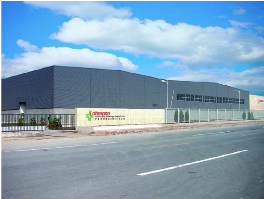
位于天津经济技术开发区的罗曼中国总部
